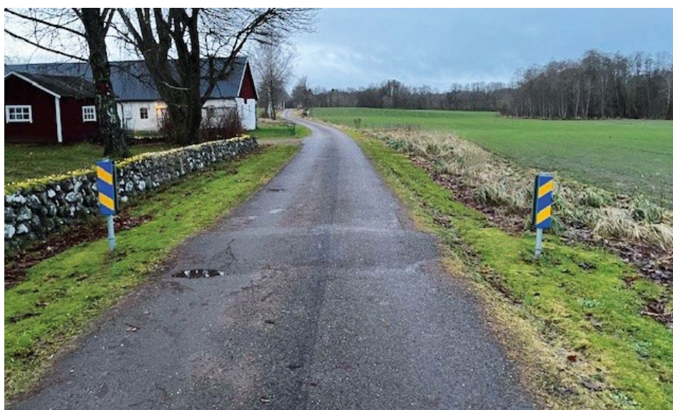
Bilden visar exempel på gupp (sk "Watts"-gupp).
